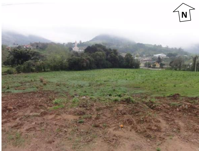
Figura 75: Vista geral para ETE do Bairro Daltro Filho.
