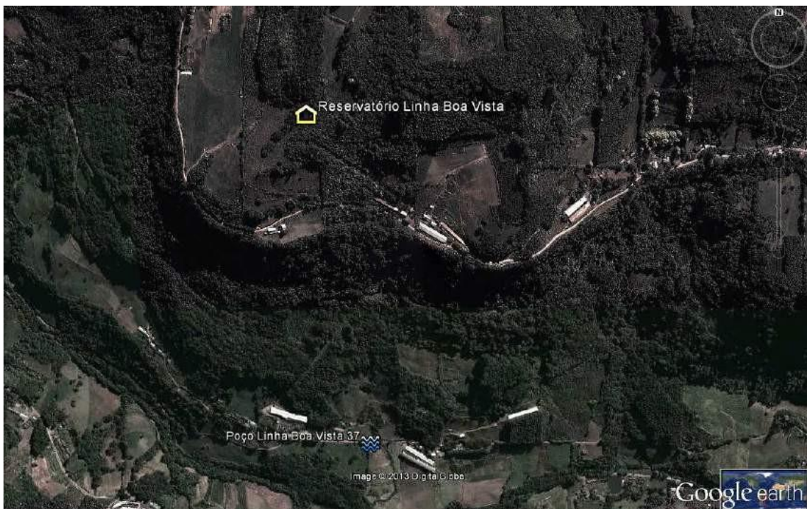
Figura 66: Vista área reservatório e poço Linha Boa Vista.
