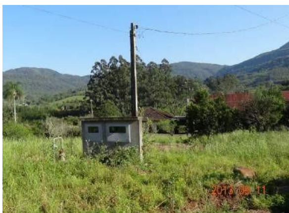
Figura 51: Poço da Linha Seca Baixa 01.
