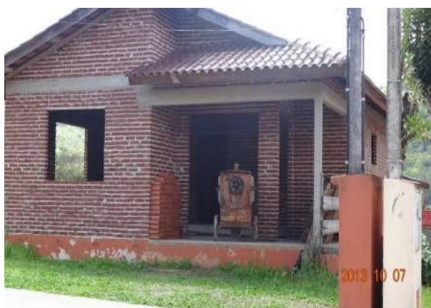
Figura 135: Casa em construção.
