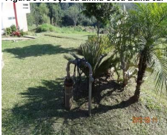
Figura 54: Poço da Linha Seca Baixa 02.
