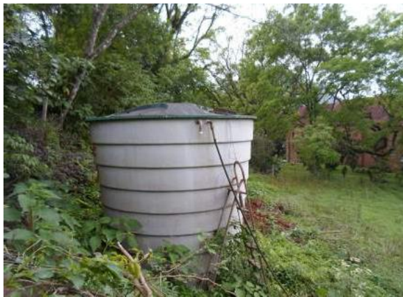
Figura 35: Reservatório de 5.000 litros
