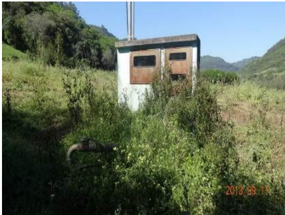
Figura 64: Poço da Linha Boa Vista 37.
