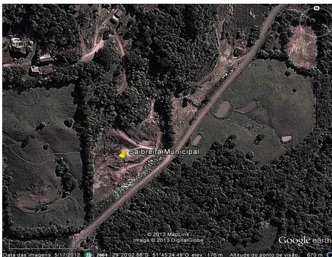
Figura 171: Vista área saibrera Municipal.
