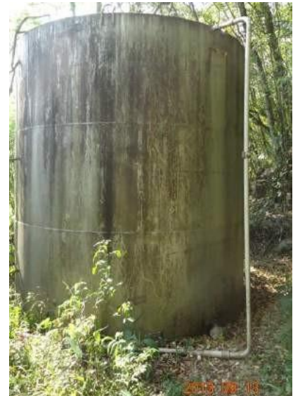
Figura 43: Reservatório da Linha Vale da Harmonia.
