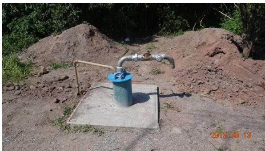
Figura 63: Poço em fase de construção localizado nas Linhas Rechts e Garibaldi
