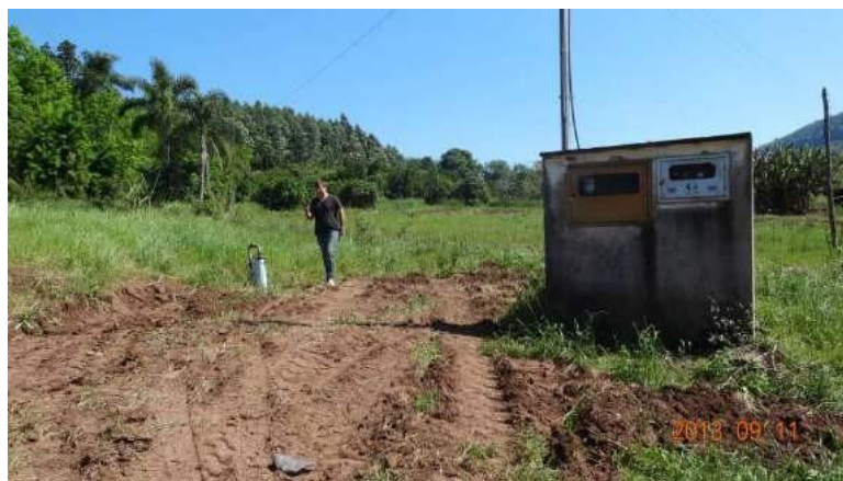
Figura 37: Poço da Linha Imhoff (Frente).
