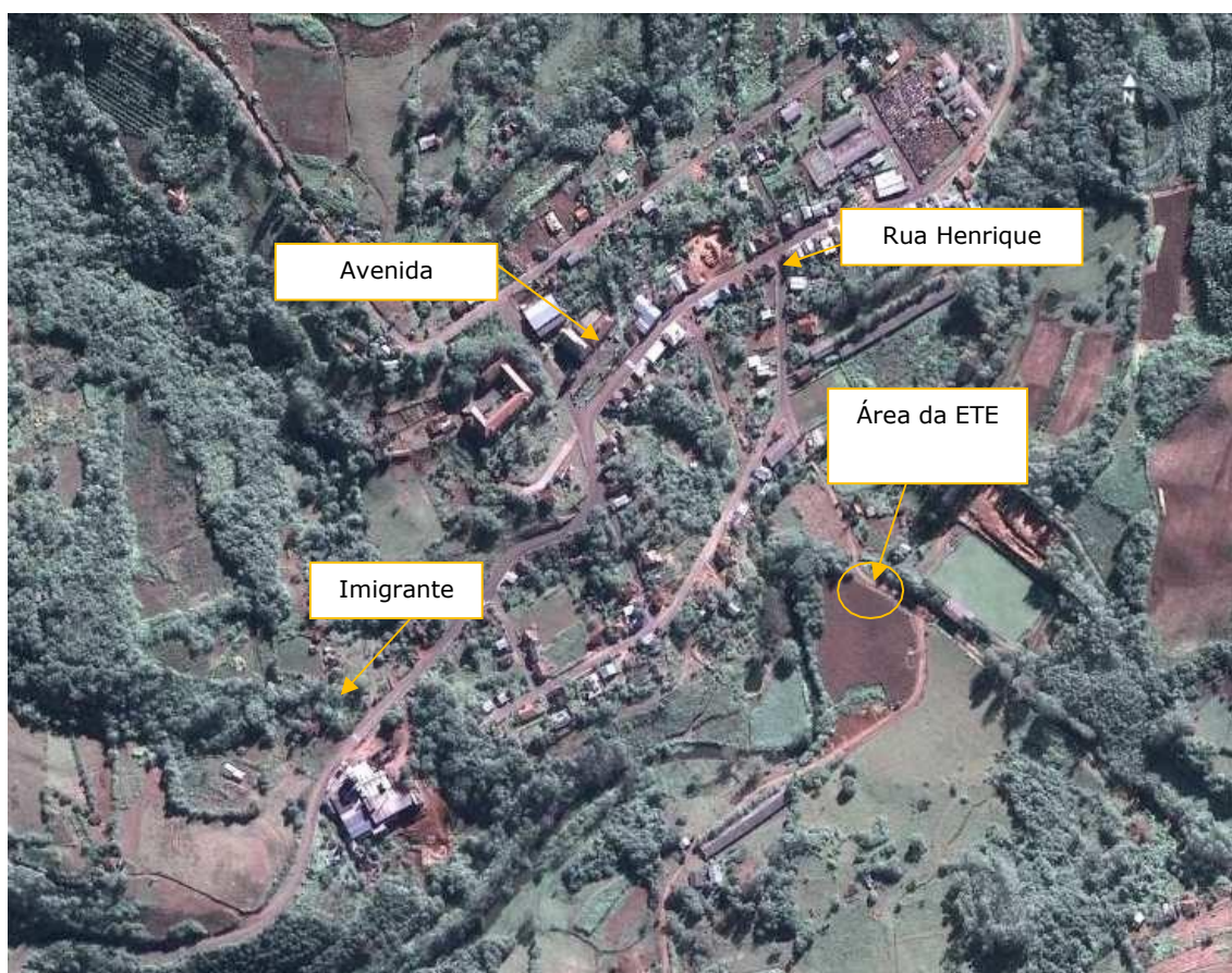
Figura 74: Vista aérea ETE, Daltro Filho.
