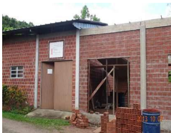
Figura 136: Empreendimento sendo ampliado.
