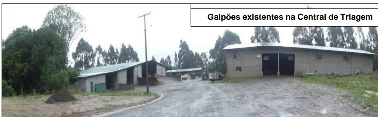
Figura 110: Vista geral da Central de Triagem.
