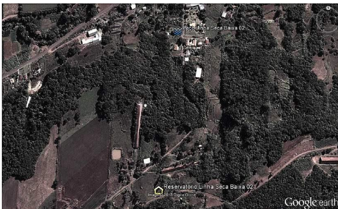
Figura 56: Vista aérea reservatório e poço Linha Seca Baixa 02.
