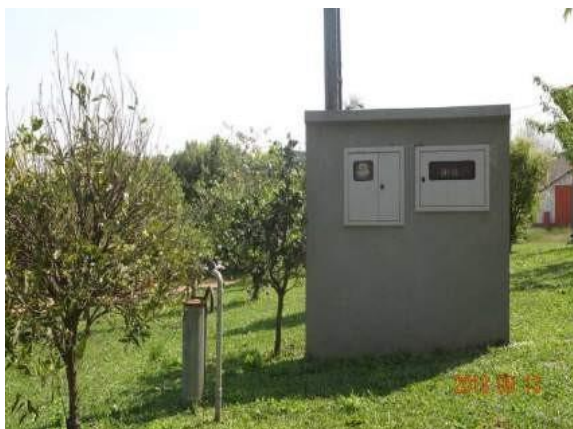
Figura 45: Poço da Linha Harmonia Alta.
