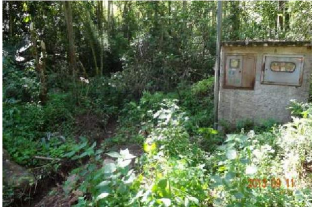
Figura 48 – Poço tubular profundo - Linha Castro Alves
