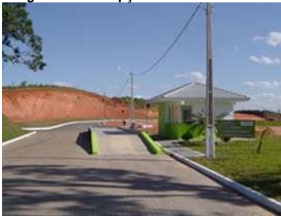
Figura 114: Recepção do aterro sanitário.
