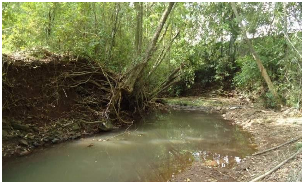
Figura 92: Ponto 14, Desmoronamento do Arroio Castro Alves.
