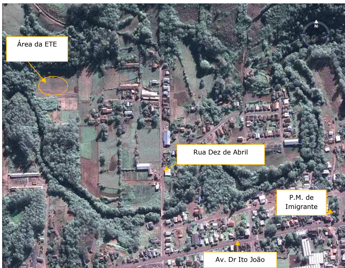
Figura 72: Vista aérea ETE, Centro.
