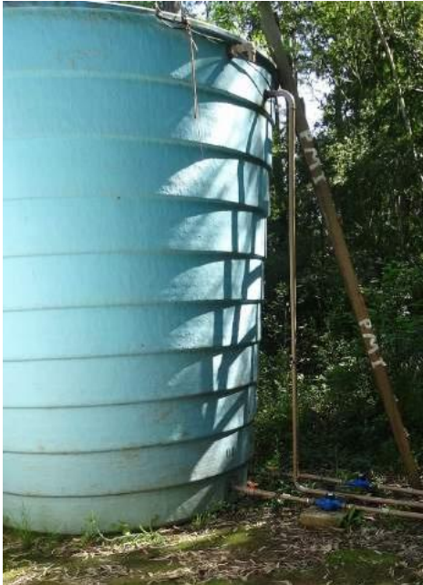
Figura 31: Reservatório Linha 11 de novembro.
